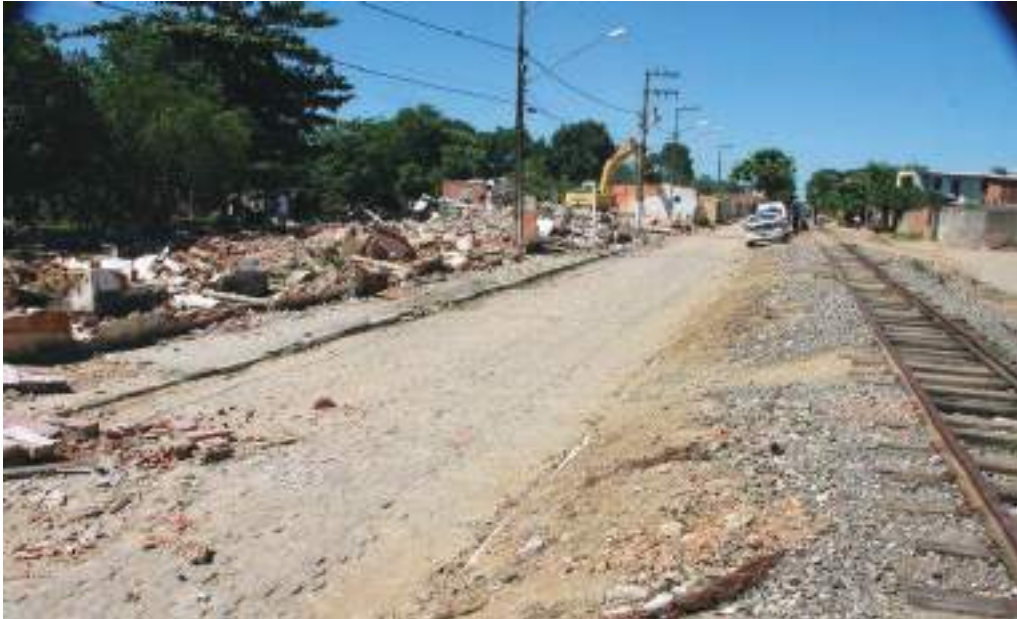
Figura 07: Máquinas da prefeitura retirando os entulhos das demolições.
