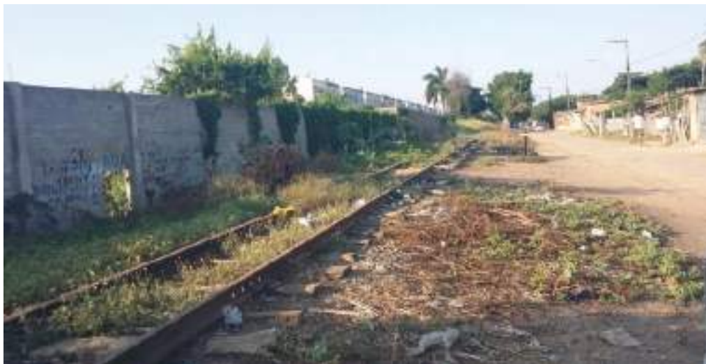
Figura 02: Margem da Linha, entre Tapera e Estrada do Contorno, próximo ao Centro Juvenil São Pedro, direção Estrada do Contorno, em 09/04/2016
