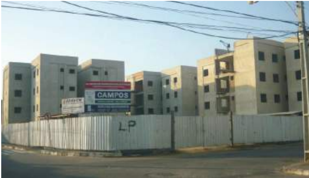
Figura 15: Obra em 28 de novembro de 2015
